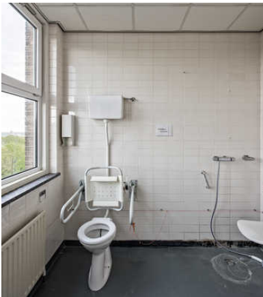
Een ruimte in De Lichtenberg in afwachting van de sloper. FOTO NICO BRONS
